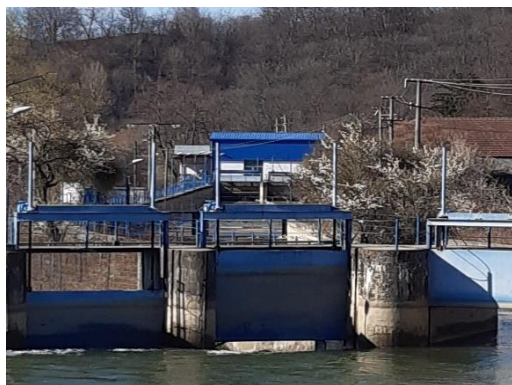
Foto Microhidrocentrală Cetățeni
