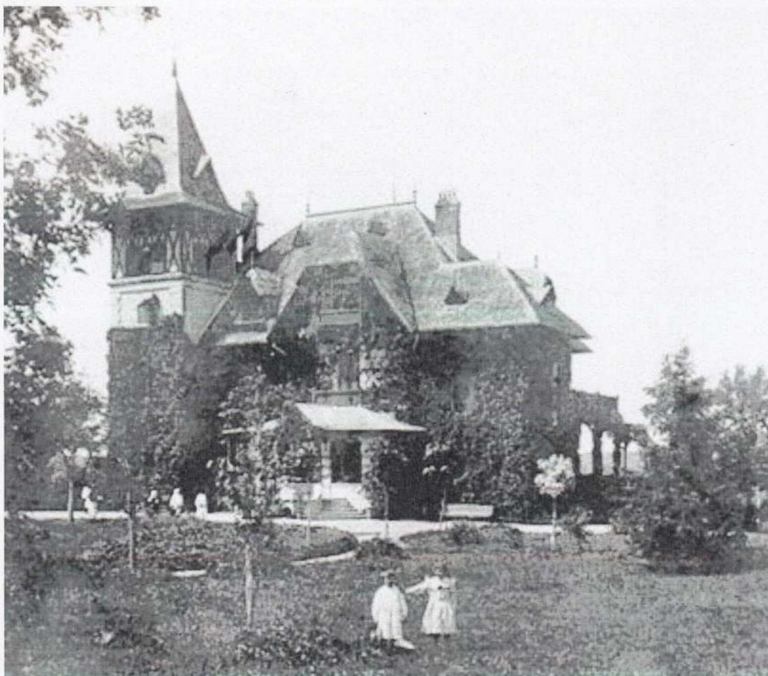
„Castelul mare”. Vedere nord-est. Imagine preluată https://arges.insse.ro/ ( www.cimec.ro )
