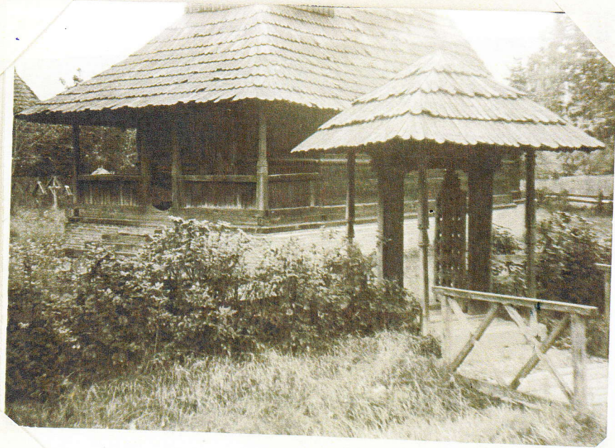
Biserica de lemn din satul Drăgulești, transferată în Muzeul Viticulturii și Pomologiei din România, de la Golești
