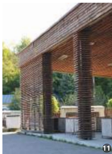
AȘA DA: [1-3] Amenajarea unui spațiu public comunitar într-un sat din jud. Harghita și integrarea noilor construcții în imaginea satului. Dintre materialele utilizate se distinge lemnul: structura, închideri, mobilier urban și învelitoarea cu draniță. Tradiția lemnului este încă vie în comunitățile maghiare din România, putând fi o bună școală pentru reluarea unei meserii tradiționale care a fost răspândită în întreaga țară. Mădăraș, jud. Harghita, arh. Györfy László-Miklós, arh. Köllő Miklós.
