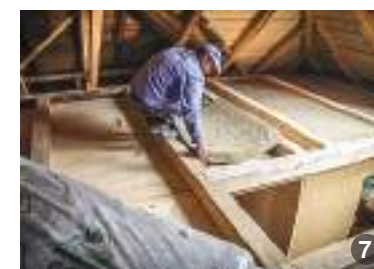
ASA DA: [4-7] Termoizolația din lână este recomandată în mod special. Folosirea unei izolații din lână sprijină o industrie a prelucrării produselor locale: în mod frecvent, lâna se aruncă, în loc să fie utilizată. Această măsură este încă la început în țara noastră, dar se folosește cu succes și pe scară largă în majoritatea țărilor europene.
