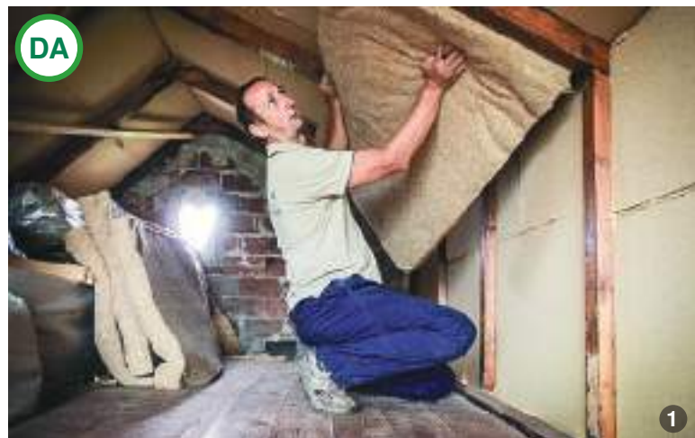
ASA DA: [1] Termoizolația din cânepă: montare rapidă și simplă. Nu este necesar un costum de protecție, deoarece produsul nu irită pielea și nu conține substanțe periculoase pentru mediu sau sănătate.
