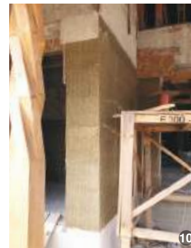
AȘA DA: [7-10] Locuință în Piscu, jud. Ilfov, construită cu „hempcrete”. Hempcrete este un material de construcție realizat dintr-un amestec de așchii din miezul fibros al cânepii, var pastă și apă, utilizat pentru pereți, fiind un bun izolator termic. Compoziția este amestecată pe șantier, înainte de a fi turnată în cofraje. Suprafața pereților poate fi lăsată aparentă sau finisată cu tencuială de var.
