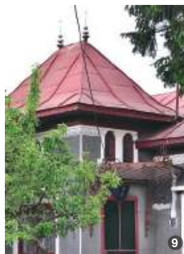
[1-3] Indiferent de compoziția volumetrică și de materialul utilizat pentru învelitoare, acoperișul locuințelor este în patru ape.
