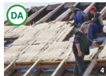
ASA DA: [2-3] Materiale termoizolante pe bază de fibre naturale: Saltele termoizolante din lână de oaie [1] și altele termoizolante din fibre de cânepă [2].
