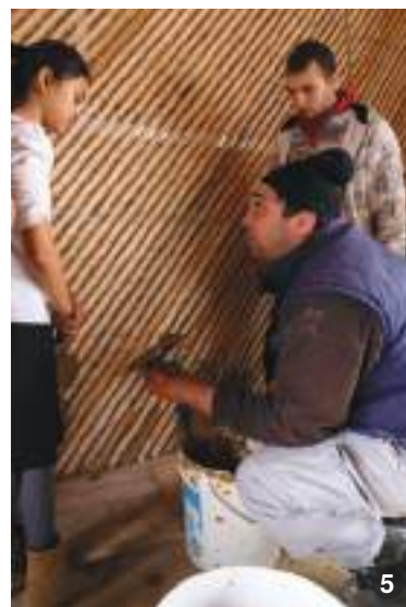
AȘA DA: [7-10] Locuință în Piscu, jud. Ilfov, construită cu „hempcrete”. Hempcrete este un material de construcție realizat dintr-un amestec de așchii din miezul fibros al cânepii, var pastă și apă, utilizat pentru pereți, fiind un bun izolator termic. Compoziția este amestecată pe șantier, înainte de a fi turnată în cofraje. Suprafața pereților poate fi lăsată aparentă sau finisată cu tencuială de var.
