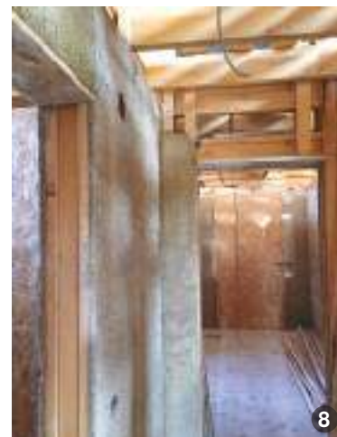
AȘA DA: [7-10] Locuință în Piscu, jud. Ilfov, construită cu „hempcrete”. Hempcrete este un material de construcție realizat dintr-un amestec de așchii din miezul fibros al cânepii, var pastă și apă, utilizat pentru pereți, fiind un bun izolator termic. Compoziția este amestecată pe șantier, înainte de a fi turnată în cofraje. Suprafața pereților poate fi lăsată aparentă sau finisată cu tencuială de var.
