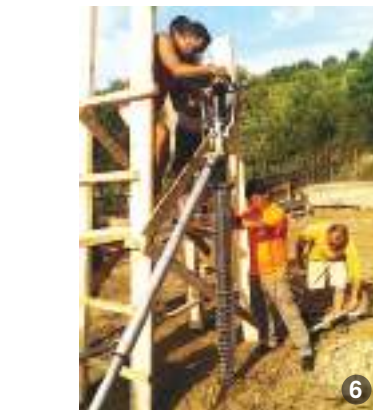
AȘA DA: [1-6] Centrul de resurse ale comunității (CERC) Boldești-Scăieni, construcție cu pereți din baloți de paie montați într-o structură din lemn [3] și tencuieli de lut pe plasă de răbiț [4, 5]. Fundațiile sunt realizate din șuruburi, reducând impactul construcției asupra terenului [6]. La realizarea proiectului a fost implicată comunitatea locală [5]. Autori: arh. Adrian Pop, arh. Anca-Maria Pop, arh. Simona Zinca, ing. Marius Șoflete; com. Boldești-Scăieni, jud. Prahova (2012-2015).
