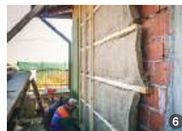
ASA DA: [4-7] Termoizolația din lână este recomandată în mod special. Folosirea unei izolații din lână sprijină o industrie a prelucrării produselor locale: în mod frecvent, lâna se aruncă, în loc să fie utilizată. Această măsură este încă la început în țara noastră, dar se folosește cu succes și pe scară largă în majoritatea țărilor europene.
