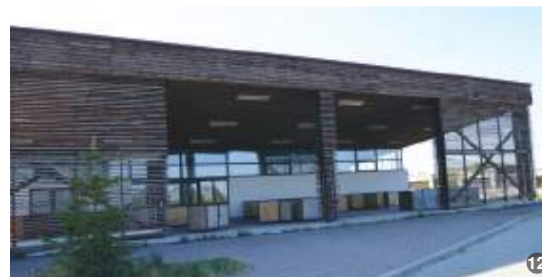
AȘA DA: [4-12] Piață agroalimentară și spațiu pentru târguri de animale. Compoziția simplă, orizontală, acoperișul detașat și materialele naturale, în tonuri neutre, utilizate pentru finisaje asigură o integrare a construcției de dimensiuni mari în sat, în timp ce riflajul orizontal din lamele de lemn asigură umbrirea spațiului pieței. Ghimpați, jud. Giurgiu.
