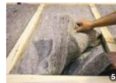
ASA DA: [2-3] Materiale termoizolante pe bază de fibre naturale: Saltele termoizolante din lână de oaie [1] și altele termoizolante din fibre de cânepă [2].
