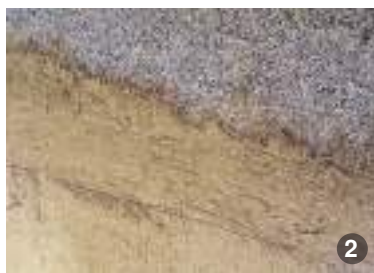
ASA DA: [1-5] Pereți cu termoizolație din Hempcrete.
