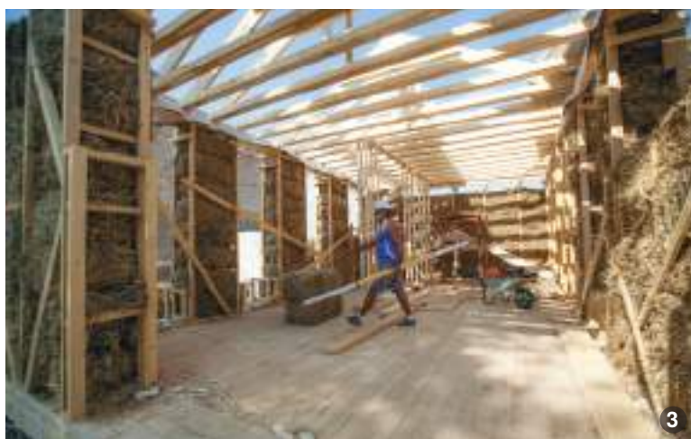
AȘA DA: [1-6] Centrul de resurse ale comunității (CERC) Boldești-Scăieni, construcție cu pereți din baloți de paie montați într-o structură din lemn [3] și tencuieli de lut pe plasă de răbiț [4, 5]. Fundațiile sunt realizate din șuruburi, reducând impactul construcției asupra terenului [6]. La realizarea proiectului a fost implicată comunitatea locală [5]. Autori: arh. Adrian Pop, arh. Anca-Maria Pop, arh. Simona Zinca, ing. Marius Șoflete; com. Boldești-Scăieni, jud. Prahova (2012-2015).
