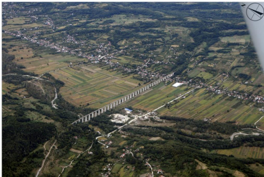
Fig. 0.128 VIADUCTUL DE CALE FERATĂ TOPOLOG – COM. CIOFRÂNGENI
