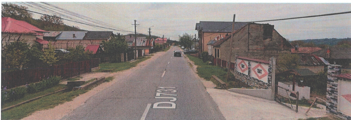
Vedere podet existent km13+500 – directia spre Piscani
