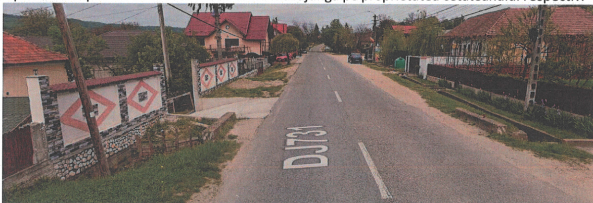
Vedere podet existent km13+500 – directia spre Domnesti
