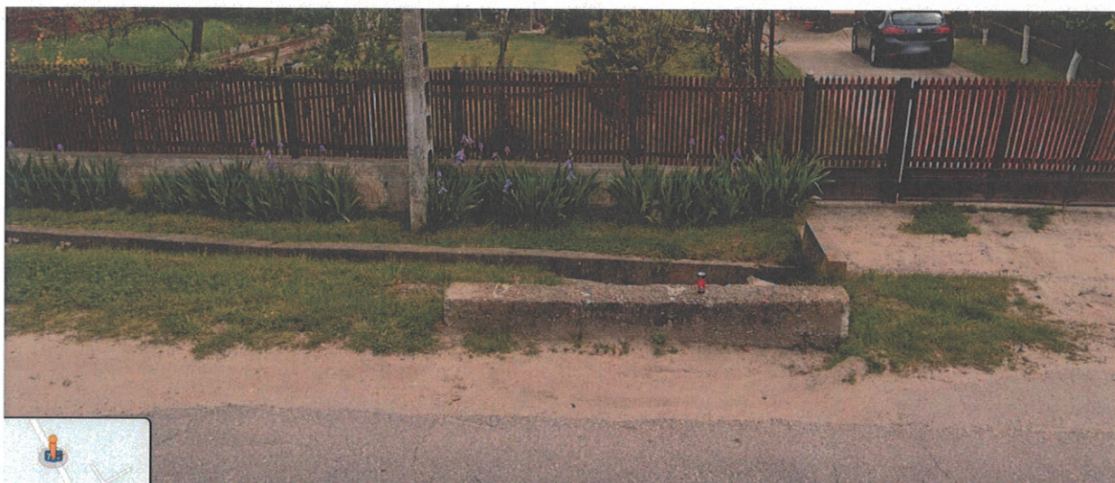
Vedere podet existent km13+500 – partea dreapta – timpan zona captare
