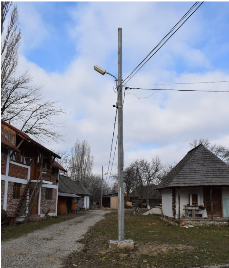
Montare/înlocuire stâlpi electricitate
