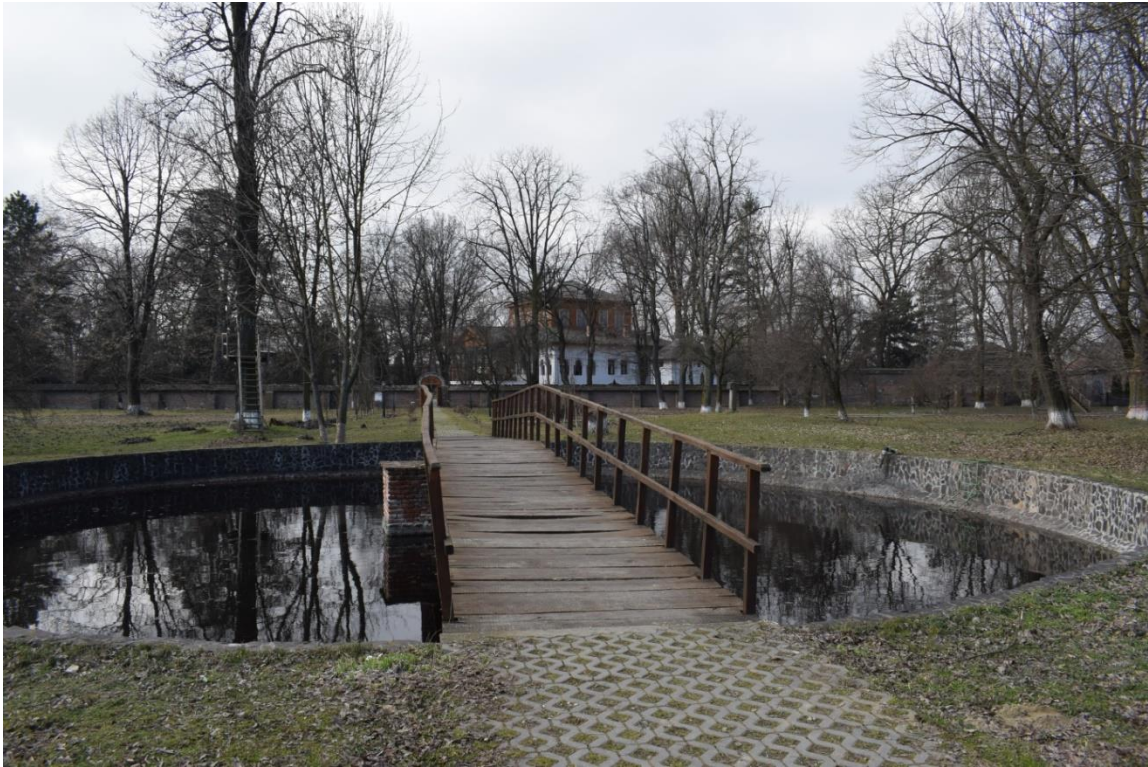
Reparații poduri și podețe
