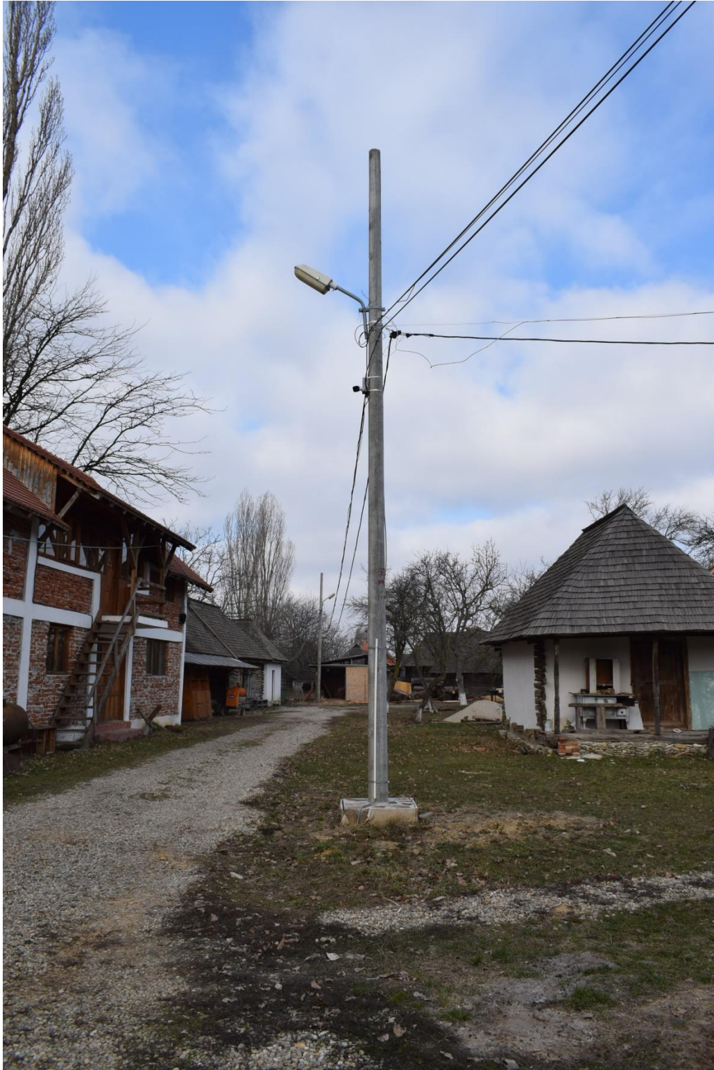
Montare/înlocuire stâlpi electricitate
