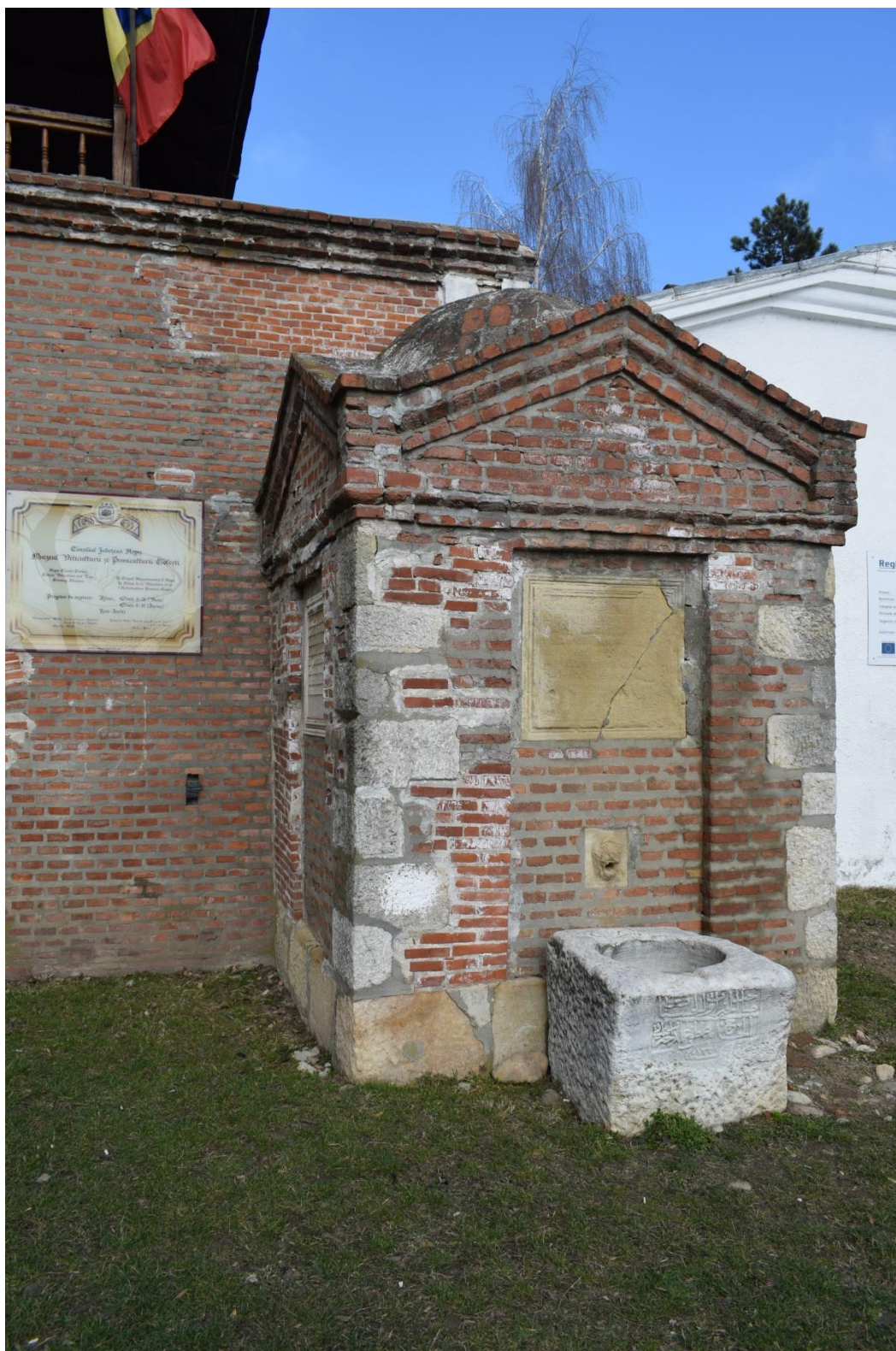
Montare instalație de apă la fântâna exterioară
