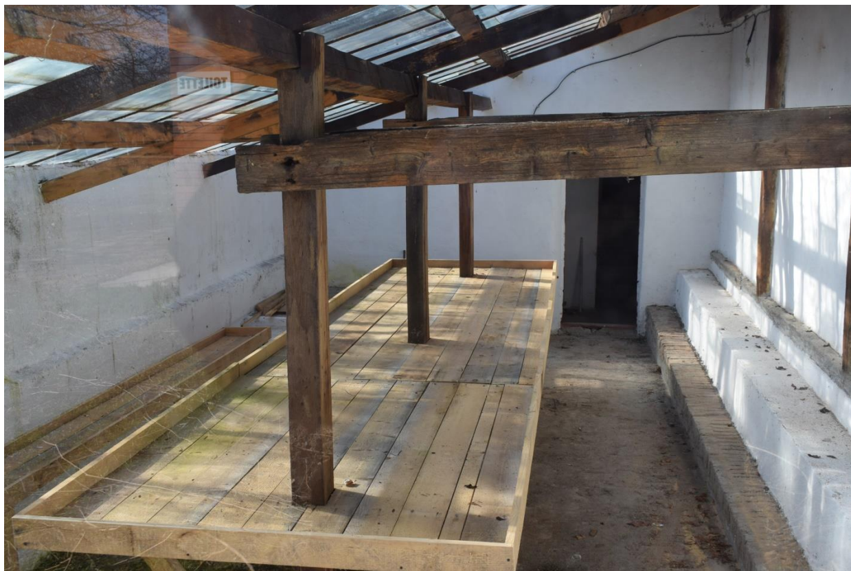
Reparații seră Golești
